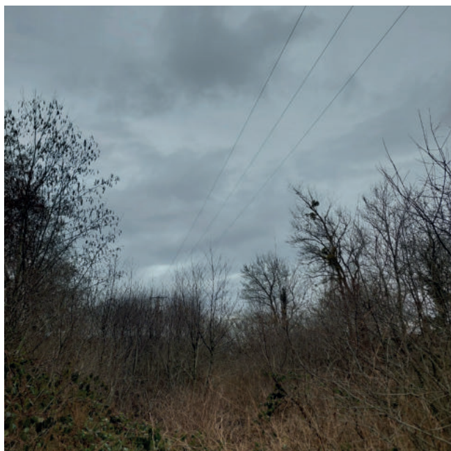
Cables électriques passant au-dessus de la zone humide débroussaillée, AVIS VERT, 2025
