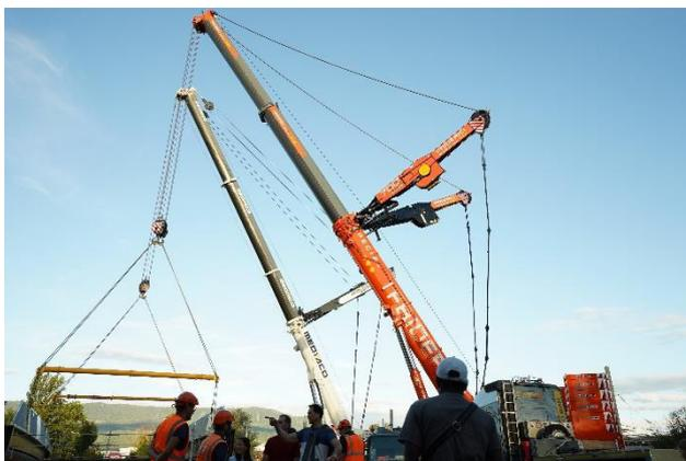
Une des étapes importantes du chantier a consisté en la pose du tablier du pont dans la nuit du samedi 10 au dimanche 11 septembre 2022. Une manœuvre impressionnante de levage au-dessus des voies ferrées d'une structure métallique à poutres latérales de portée 26 m. Lors de cette soirée, les riverains du chantier et personnes intéressées par les projets de mobilité étaient les bienvenus sur site pour un temps d'échange convivial en présence des élus, entreprises et partenaires.
