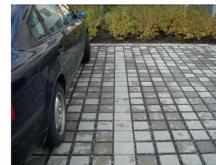
Pavés poreux à joints gravillonnés
