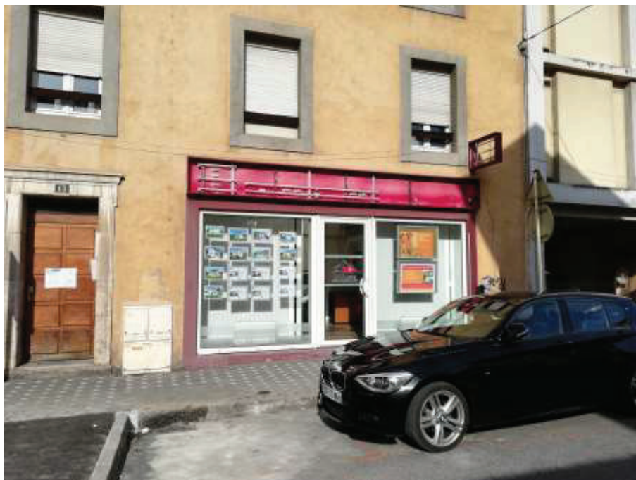
Enseignes en mauvais état, Annemasse, septembre 2019
