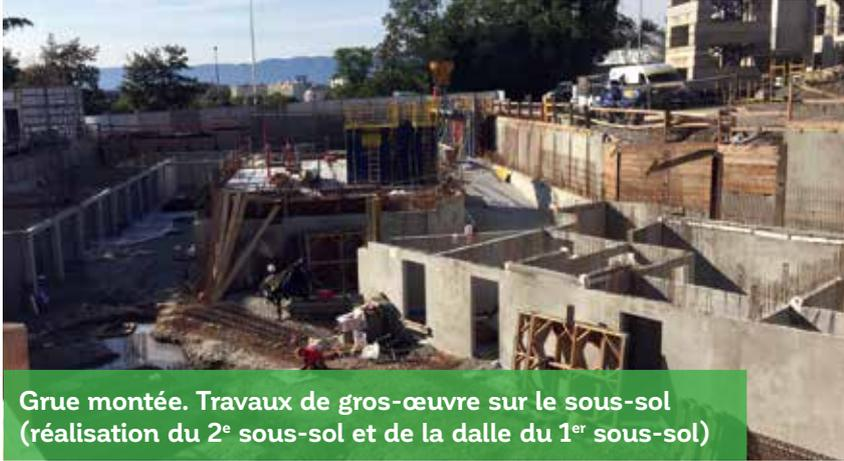
Grue montée. Travaux de gros-œuvre sur le sous-sol (réalisation du 2<sup>e</sup> sous-sol et de la dalle du 1<sup>er</sup> sous-sol)
