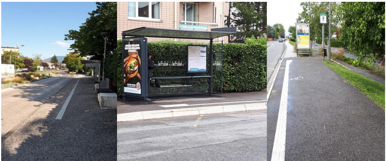
Station du BHNS à Ville-la-Grand avec un revêtement qualitatif et des équipements (mobilier, distributeurs, information voyageur dynamique)
