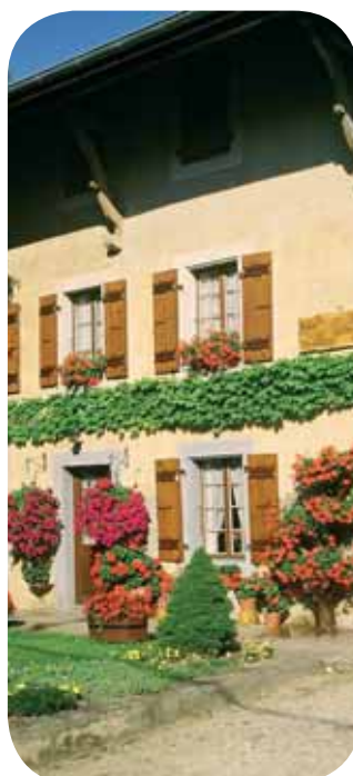
Maison ancienne à Saint-Cergues
