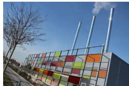
La chaufferie bois d'Annemasse
