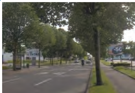
Exemple d'aménagement de voirie (hors territoire Annemasse Agglo) : les plantations séparent la voie cyclable de la bande roulante, une voie centrale est réservée pour tourner à droite ou à gauche, la réduction de la largeur de voie incite à rouler moins vite
