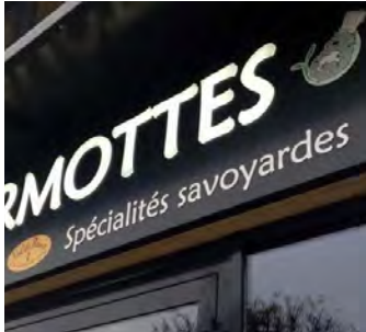
lettres rapportées lumineuses sur linteau sous arcade
