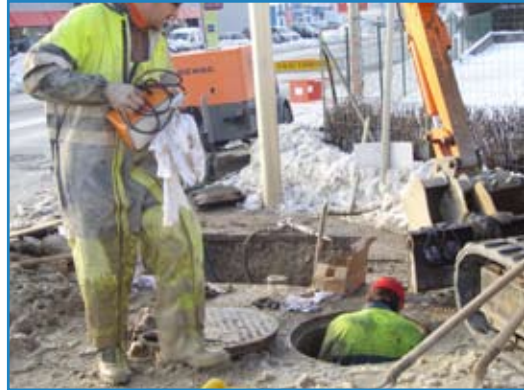
Intervention dans un regard
