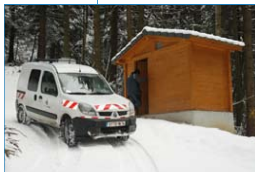
Unité de désinfection du Fieu (Saint-Cergues)
